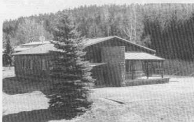
Stanice POLOM – hlavní budova
