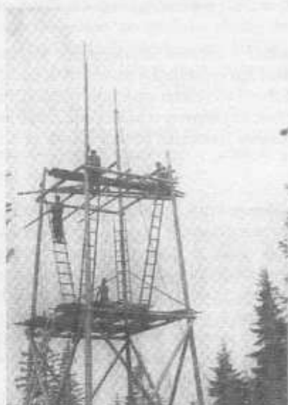
Stavba měřické věže pro triangulační měření
