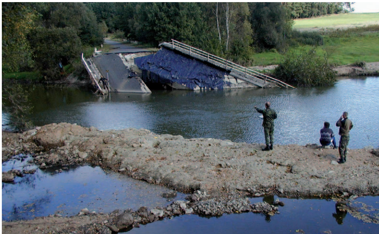
Obr. 11 Geodetické práce při zabezpečení výstavby mostního provizoria (foto archiv VGHMÚř)
