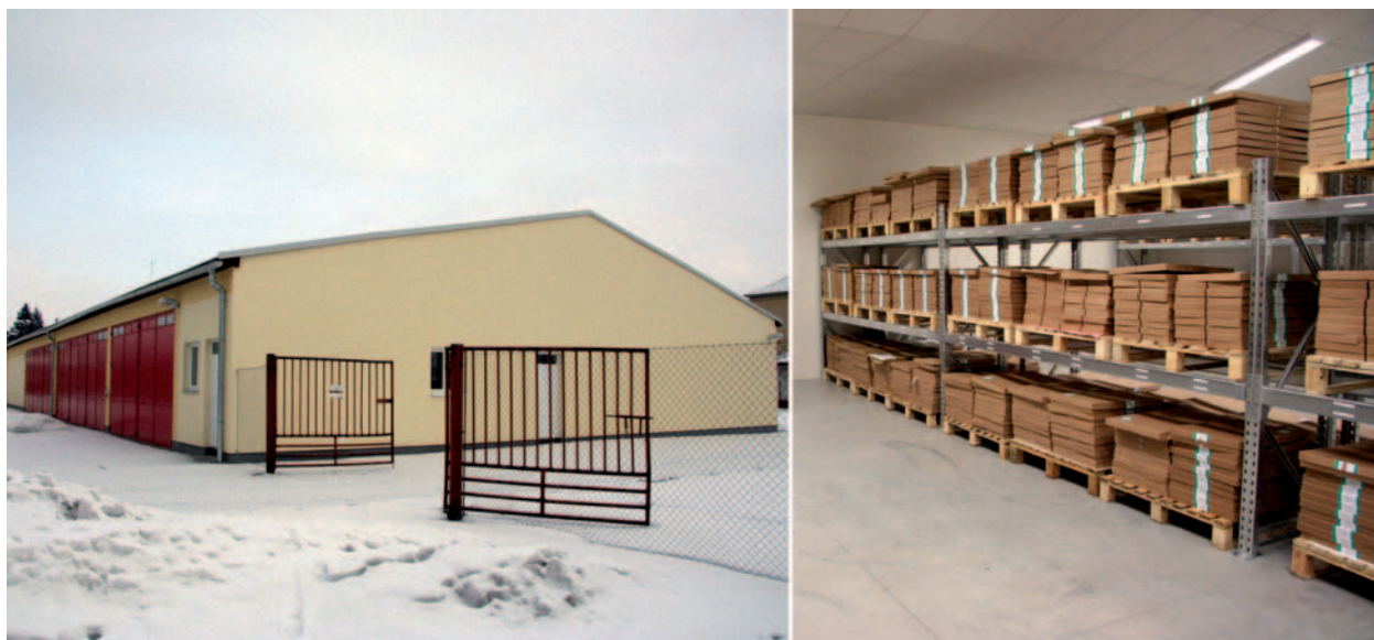
Obr. 8 Objekt nového centrálního skladu map ve VGHMÚř v Dobrušce (foto archiv VGHMÚř)
