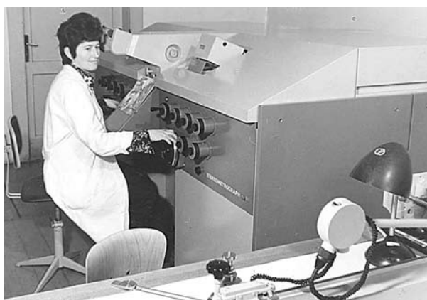
Obr. 13 Přístroj k fotogrammetrickému vyhodnocování polohopisu a výškopisu s možností grafického nebo digitálního výstupu – stereometrograf F (ve VTOPÚ)
