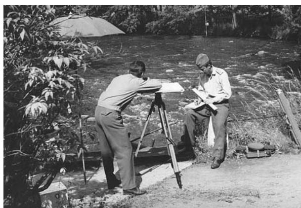
Obr. 11 Mapování metodou stolové tachymetrie
