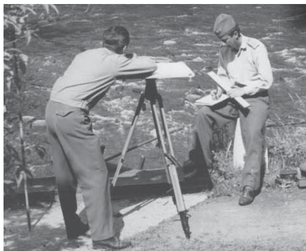
Obr. 1 Měření metodou stolové tachymetrie – ilustrační fotografie
