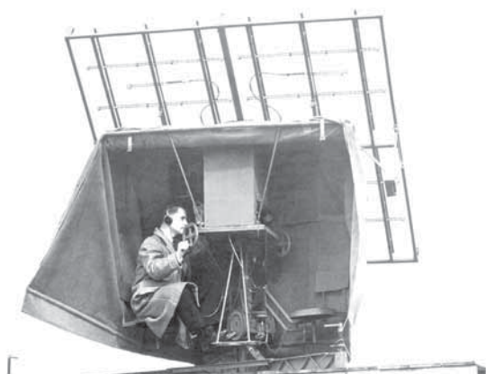
Obr. 3 Radioteodolit SCR-658 využívaný v době druhé světové války armádou USA
