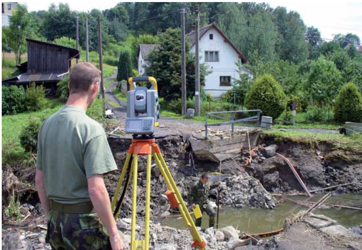
Obr. 11 Geodetické práce při přípravě výstavby mostních provizorií po povodních v roce 2009 v obci Veselé
