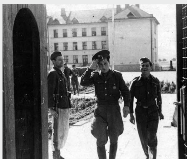
▲ Pohled do vchodu do nově vybudovaných dobrušských Kasáren Jana Gayera.
