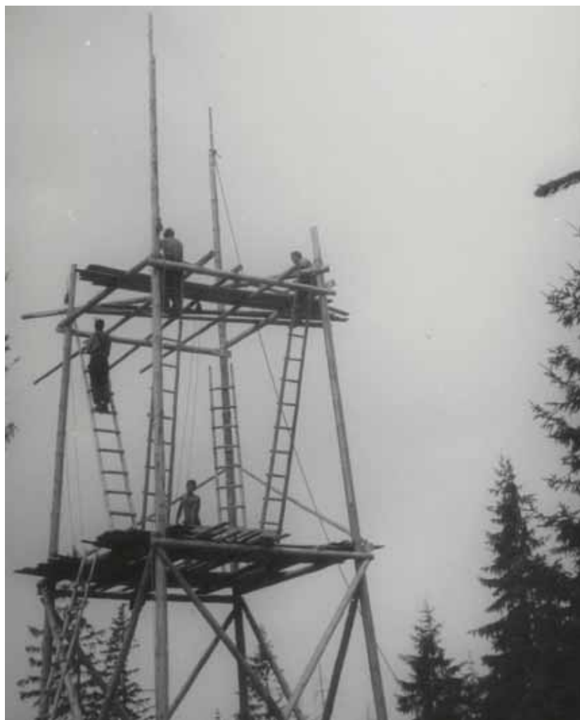
Obr. 5 Výstavba jedné z měřických věží
