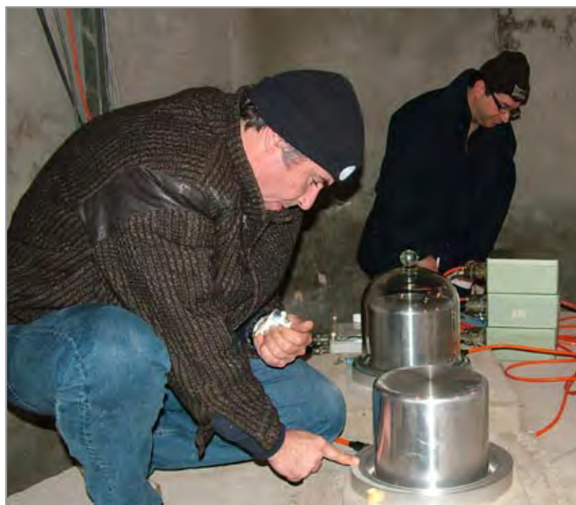
Obr. 37 Instalace seismometrů Streckeisen STS-1 specialisty MedNet
