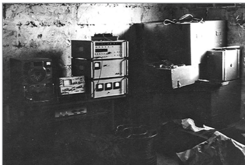
Obr. 14 Instalace technologie fotografické registrace UDZ v observačním pavilonu
