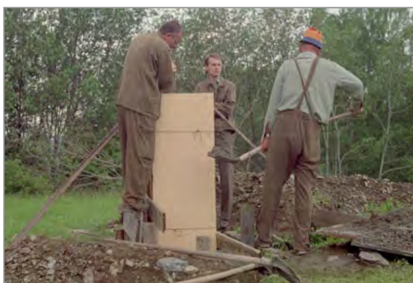
Obr. 28 Budování observačního stanoviště POL1
