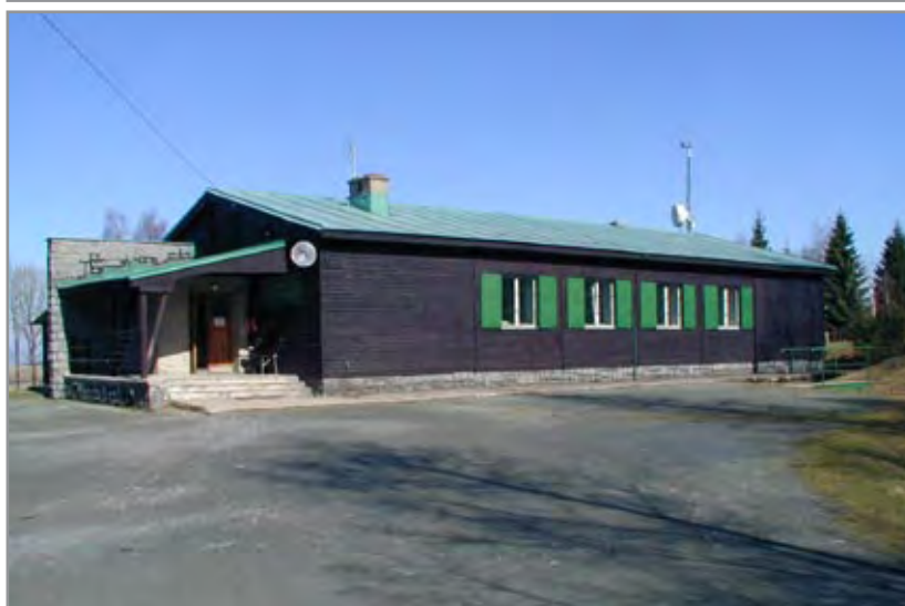
Obr. 36 Staniční budova na počátku nového tisíciletí v různých ročních obdobích
