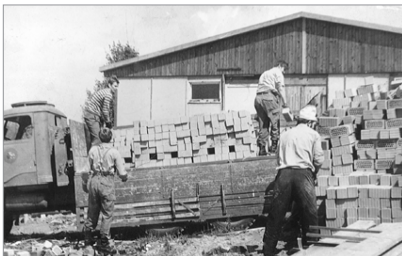
Obr. 5 Budování objektu „Na Skále“
