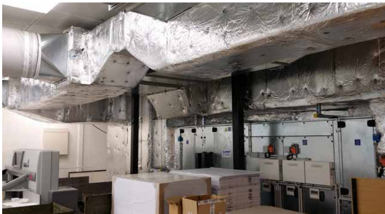
Obr. 6 Rekonstruovaná vzduchotechnika v prostorách tiskového stroje RAPIDA 105
