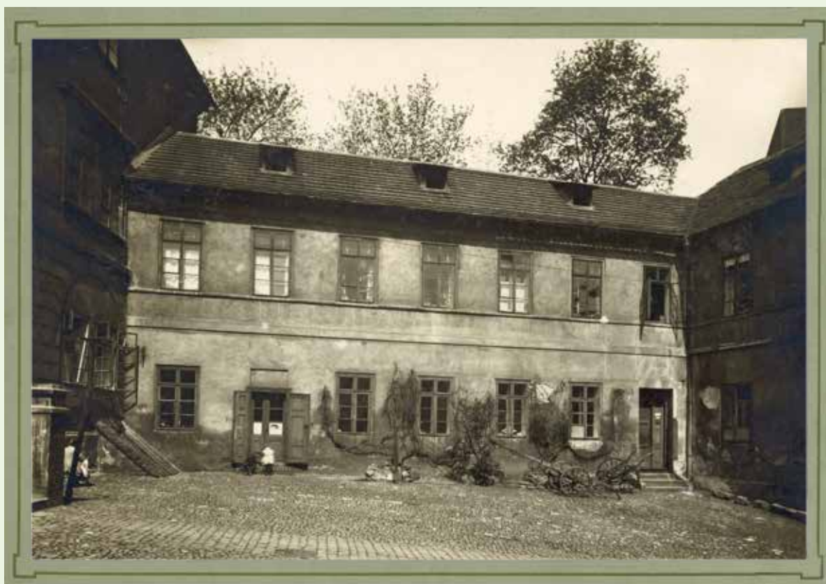
Dům Újezd č. 23 (Praze III) byl první budovou využívanou ústavem od roku 1919
