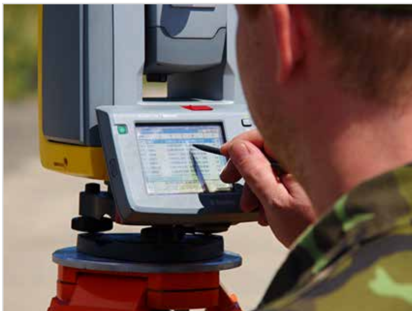
Obr. 2 Pracovník oddělení geodzie při zaměřování prostoru mostního provizoria
