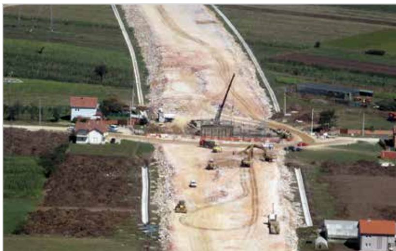
Obr. 11 Výstavba dálnice na jih do Makedonie, prověření stavu průzkumem z vrtulníku tzv. Heli Recce
