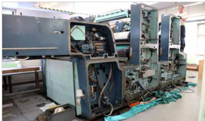
Obr. 1 Demontáž tiskového stroje Planeta 926-Varimat
