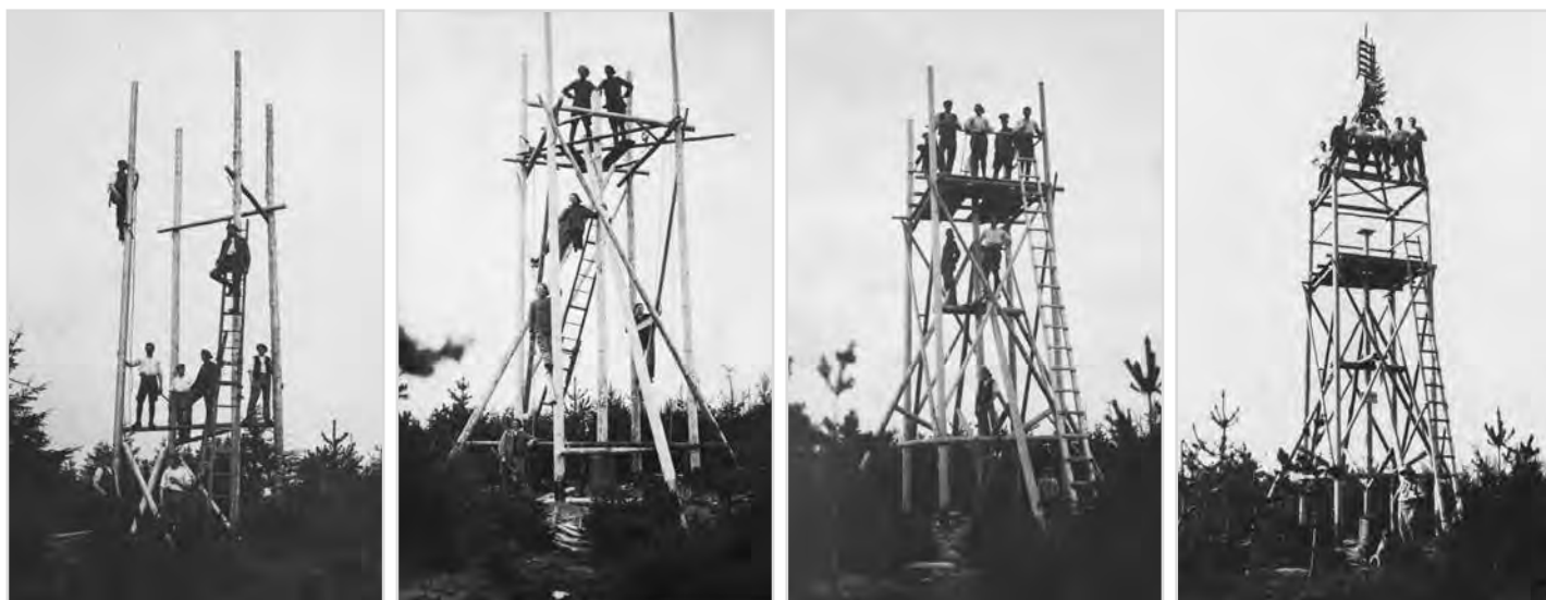
Obr. 4 Stavba měřického signálu na trigonometrickém bodě Blažkov
