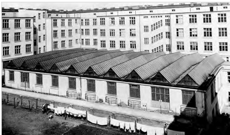
Obr. 9 Objekt tiskárny na nádvoří VZÚ
