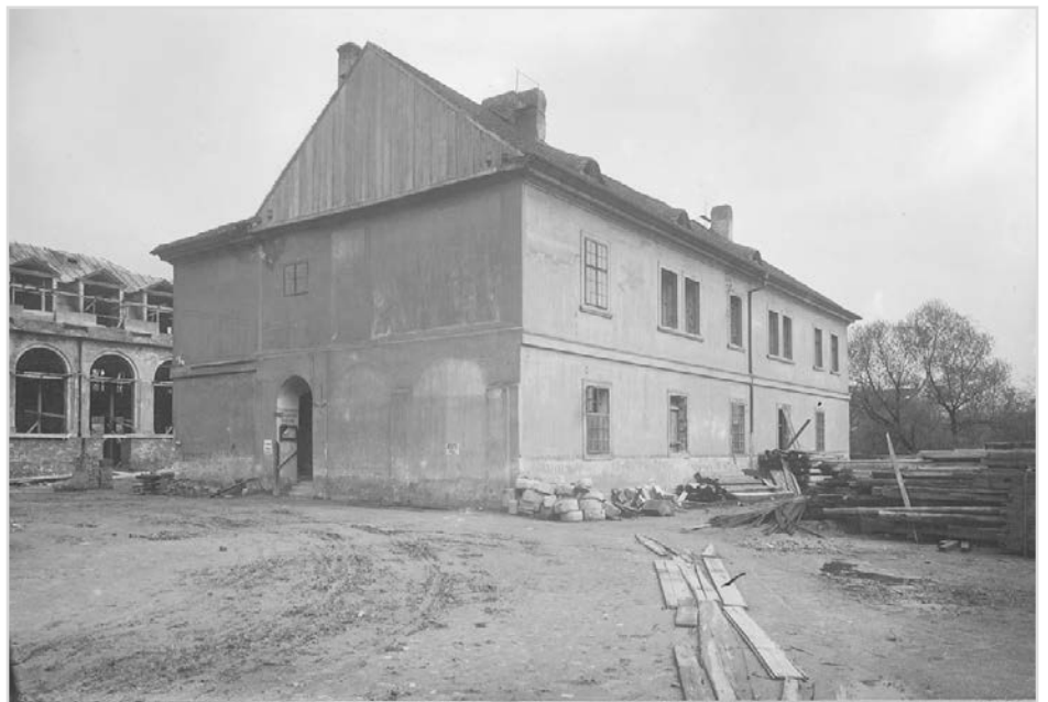
Obr. 3 Fotografie objektu ústavu „Zbrojnice“ [10]
